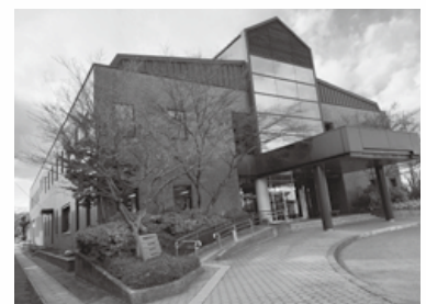
いよいよ始まる 総合文化センター改修工事
